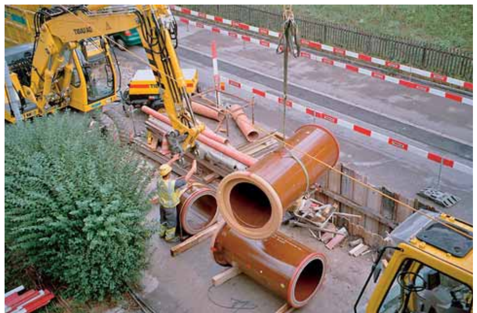
Mit einer systematischen Bewirtschaftung der Entwässerungsanlagen kann mittel- und langfristig viel Geld gespart werden. (Bild: Stadt Zürich)
