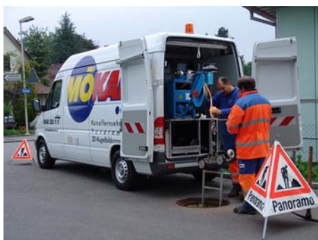
Der PANORAMO wird in den Schacht eingesetzt
